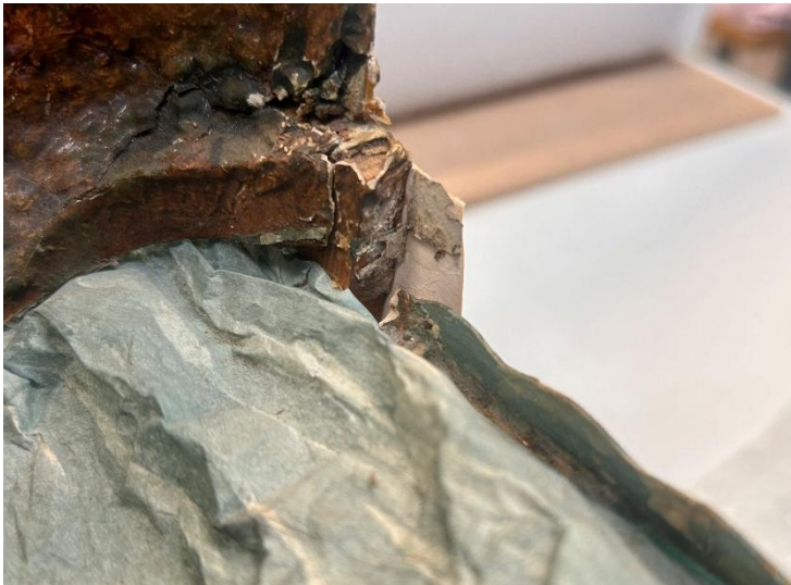
Figure 65 Décollement et rupture du carton anciennement maintenu par les décors architecturaux
